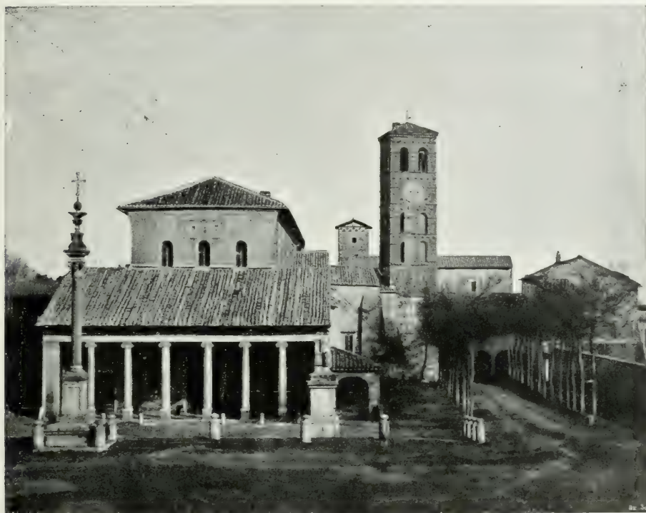
Fig. 10. — Église de Saint-Laurent hors les Murs, avant les derniers agrandissements du cimetière.
